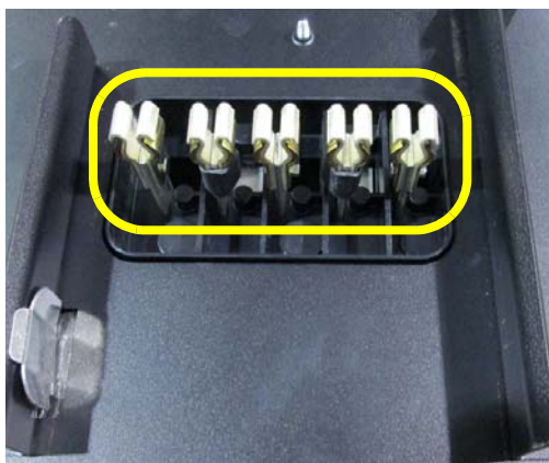
Figura 6: Inspección de las mordazas enchufables
