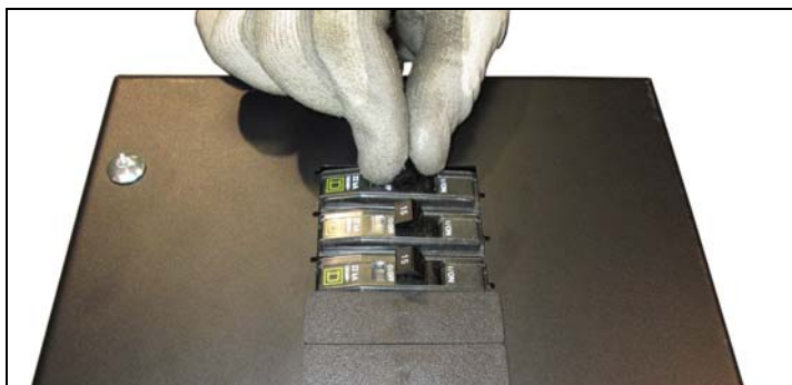
Figure 15 : Mise de l'unité enfichable en position de marche (I) et d'arrêt (O)
