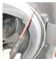
2 Gebruik de platte schroevendraaier voor hefboomwerk en verwijder de externe klem
