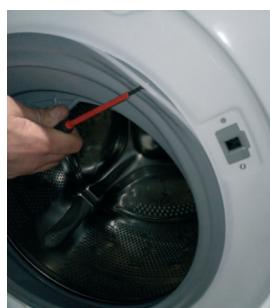
**2** Utilizar a chave de fendas de cabeça plana para pressionar e retirar o grampo externo
