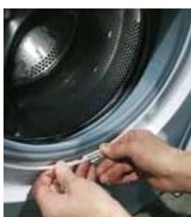
**9** Monteer de packing op de kast. Bevestig de externe klem en draai deze vast (indien nodig met een tang)
