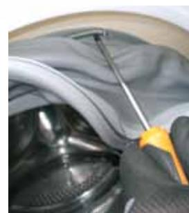
**4** Verwijder de klem op de buis met behulp van een vlokke schroevendraaier
