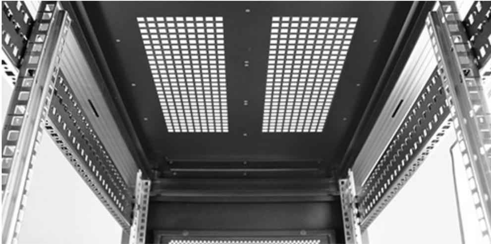
Lo sportello posteriore del rack è costituito da una griglia, mentre quello anteriore in vetro è ventilato. In questo modo è possibile aumentare il flusso dell'aria e offrire un economico raffreddamento passivo in grado di favorire il funzionamento delle apparecchiature a una temperatura ottimale.
