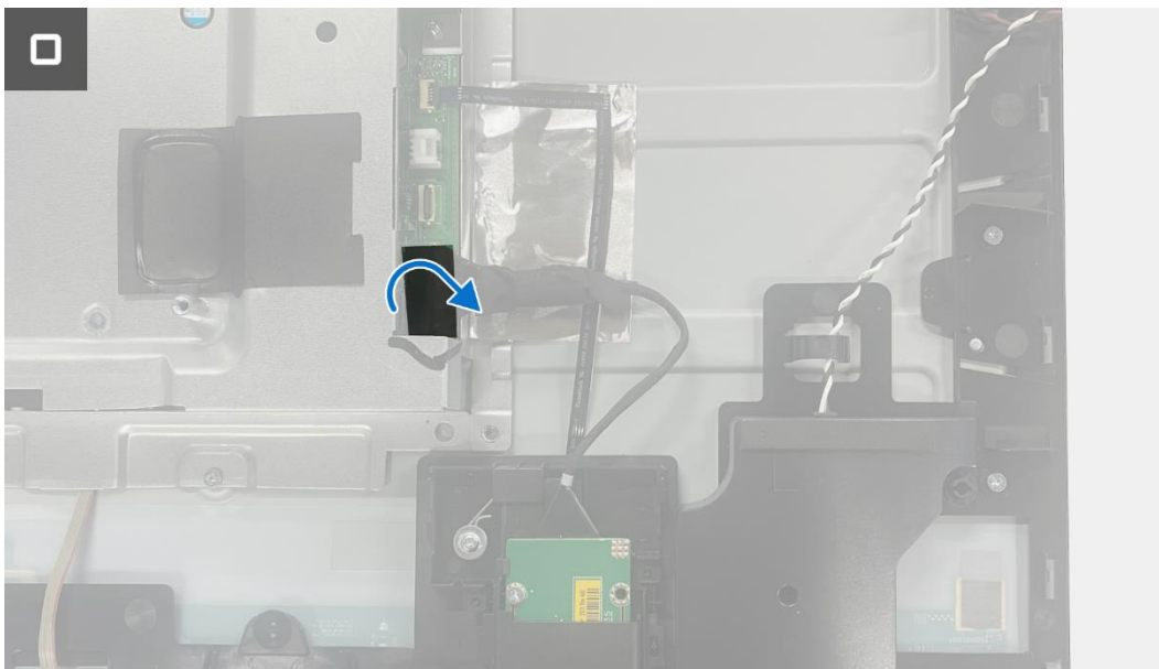
Figura 23. Instalación de la placa QAP
