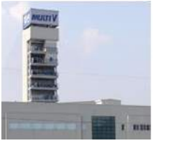
Uzun Borulama ve Kot Farkı Testleri
