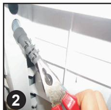
3. Αποσυνδέστε τον εύκαμπτο σωλήνα από τη σύνδεση του στη γέφυρα.
