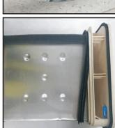
6. Kondenzator ponovno namestite, pri tem pa pazite, da je pravilno obrnjen (kot kaže puščica) ter da trdno potisnete na njegovo mesto. Oba vzvoda ponovno zaprite tako, da ju obrnete v smeri urnega kazalca. Z o b r a č a n j e m v desnozapahniteoberoci. Prepričajte se, da je kondenzator trdno v podnožju.
