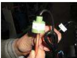
Figuur 28: Hogedruksensor
