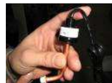
Figuur 29: Lagedruksensor
