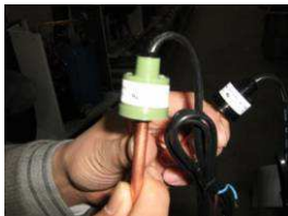
Abbildung 28: Hochdruckfühler.
