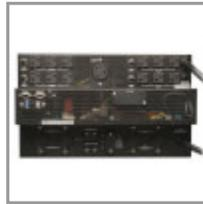
Este UPS de 208V a 120V protege a los equipos de bajo y alto voltaje contra los daños por apagones, caídas de voltaje, sobretensiones y ruido en la línea.
