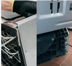
2. S pomoću cijevnog ključa 15 uklonite vijke koji pričvršćuju poklopac kućišta
