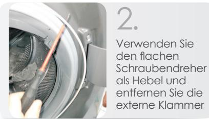
Verwenden Sie den flachen Schraubendreher als Hebel und entfernen Sie die externe Klammer
