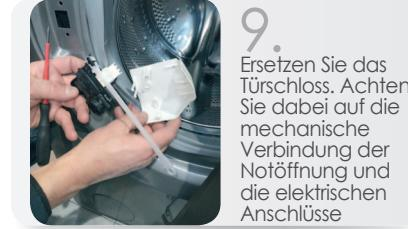
Ersetzen Sie das Türschloss. Achten Sie dabei auf die mechanische Verbindung der Notöffnung und die elektrischen Anschlüsse
