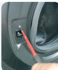
4. Χρησιμοποιώντας μηχανικό κλειδί τύπου Torx, αφαιρέστε τις βίδες στερέωσης της ασφάλειας πόρτας
