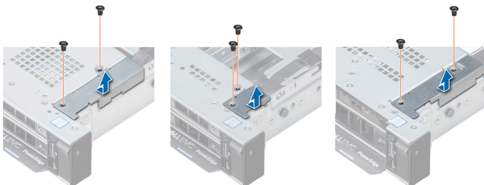
Ilustración 123. Extracción de la cubierta de cables
